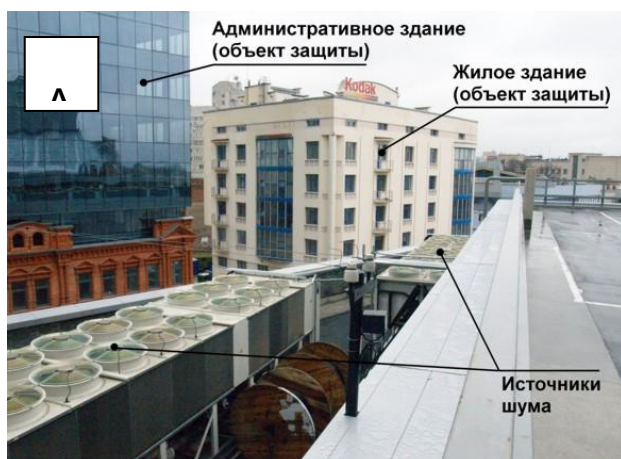
Рис. 1. Вентиляционное оборудование и прилегающие к центру объекты защиты: А. - До шумозащитных мероприятий; Б. - После шумозащитных мероприятий.
