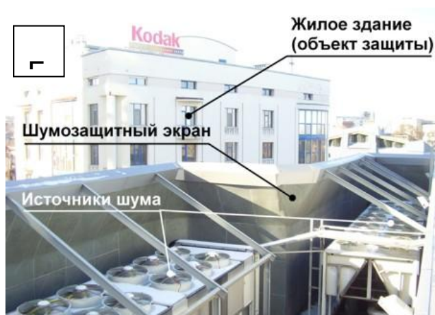
Рис. 1. Вентиляционное оборудование и прилегающие к центру объекты защиты: А. - До шумозащитных мероприятий; Б. - После шумозащитных мероприятий.
